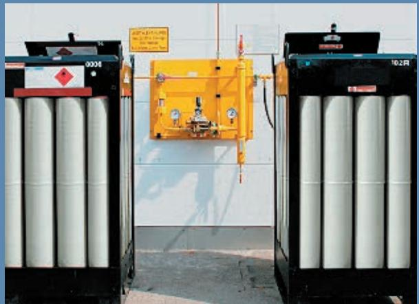
Разрядная раampa с подключенными 16-местными ацетиленовыми бандлами
