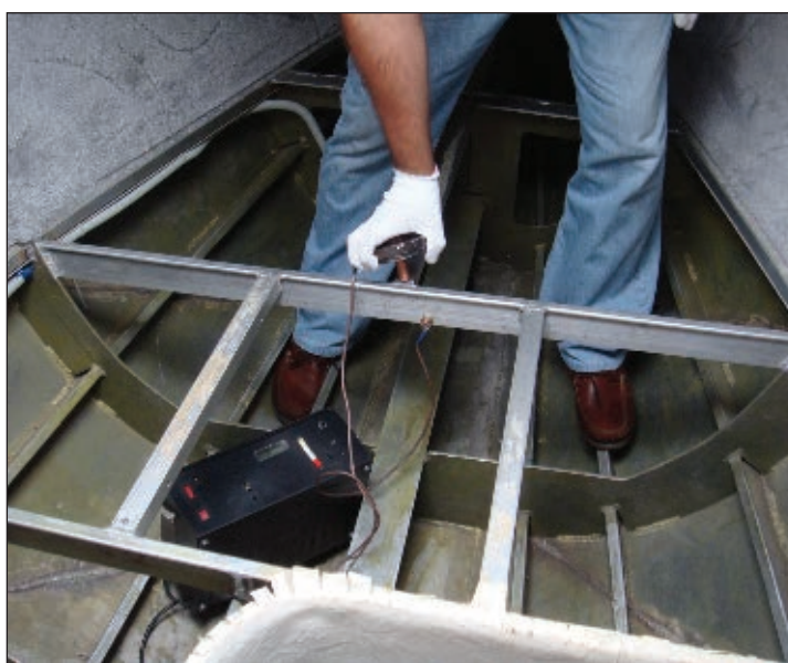
Рис. 6. Электродинамическая обработка стыковых швов поперечной жесткости
