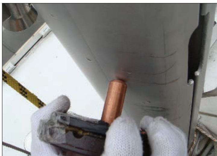
Рис. 3. Электродинамическая обработка сварных соединений стоек подкрепления корпуса
