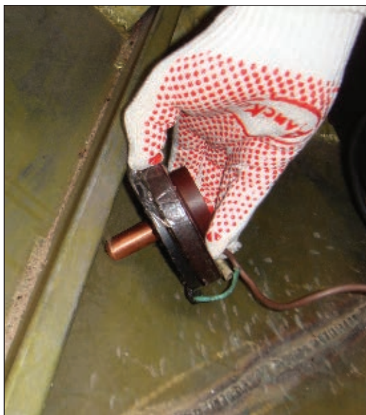
Рис. 4. Электродинамическая обработка угловых сварных соединений стрингеров
