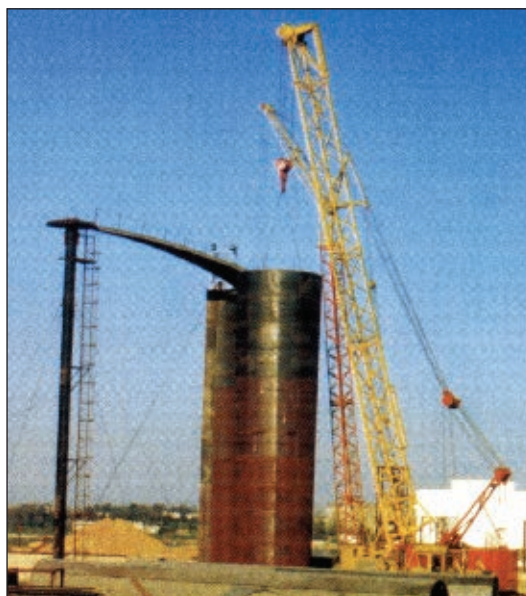
Рис. 4. Монтаж резервуара вместимостью 10 000 м 3 из рулонированных конструкций
