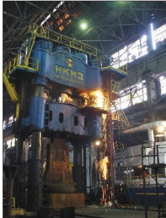
Рис. 4. Резка юго-восточной колонны пресса под архитравом после удаления первого куска (под рабочей траверсой)
