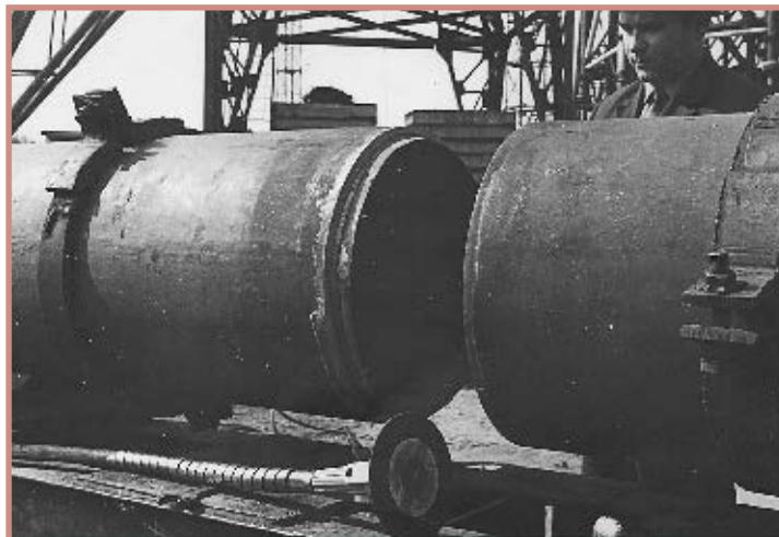
Рис. 3. Сборка монтажных стыков
