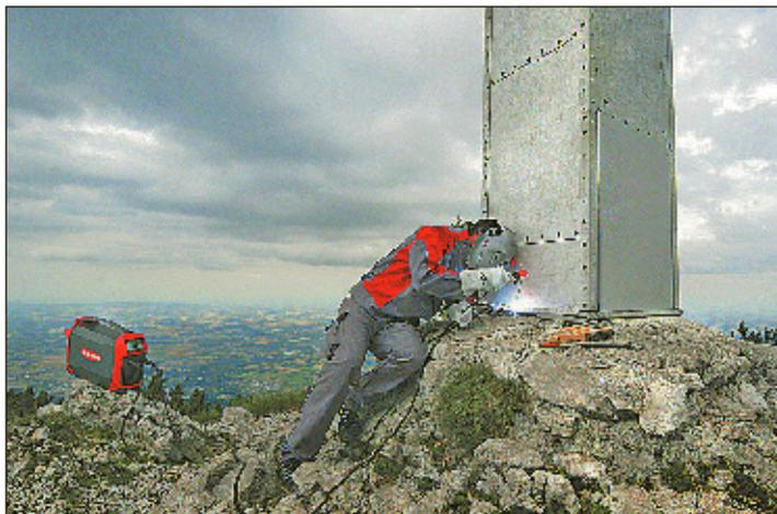
Система Fronius AccuPocket 150/400 с возможностью работы от аккумуляторной батареи позволяет выполнять сварку MMA и TIG без подключения к электросети
