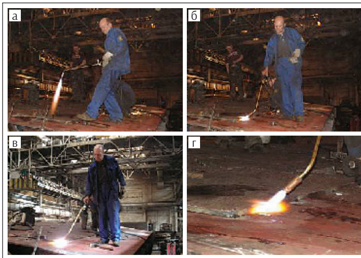
Рис. 6. Процесс подготовки двух листов под сварку барабана для шахтно-подъемной машины (ШПМ) с помощью горелки ГЗУ-04: а — начало правки верхнего листа; б, в — процесс нагрева и правки верхнего листа, г — окончание процесса
