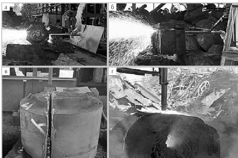
Рис. 7. Машинная кислородная резка различных заготовок вертикальным и горизонтальным резаками в ОАО «Уралмашзавод»: а — резка слитка горизонтальным резаком при его перемещении снизу вверх; б — резка слитка горизонтальным резаком при его перемещении слева направо; в — резка шайбы вертикальным резаком при его перемещении к машине; г — резка прибыли с усадочной раковинной вертикальным резаком при его перемещении от машины
