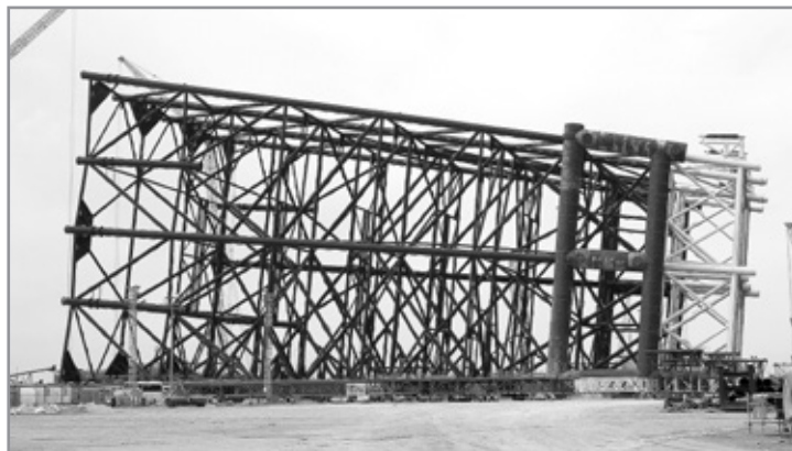
Рис. 1. Основание платформы МСП-7 с приваренными понтонами
