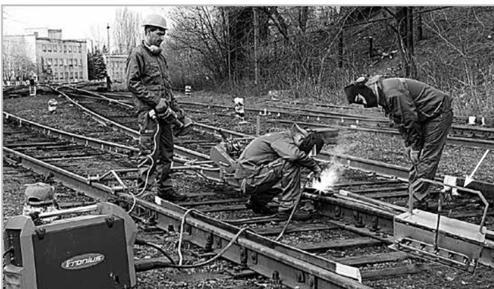
Рис. 7. Ремонт дефектного участка рельсового пути наплавкой с использованием установки УНР-ЖД (на переднем плане – справа).
