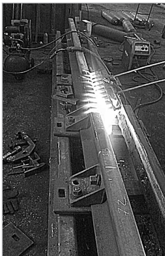
Рис. 4. Процесс нагрева участка рельса под наплавку горелкой ГЗУ6-ЖД
