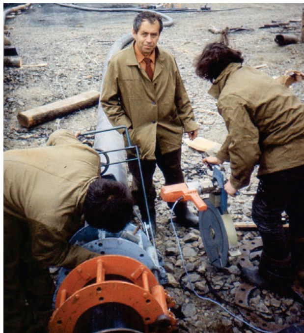
Строительство водопровода из полиэтиленовых труб наружным диаметром 315 мм под руководством сотрудника отдела № 80 ИЭС к.т.н. Минеева Э.А. для промывки золотоносной руды в районе г. Беличан Магаданской области (май 1986 г.)
