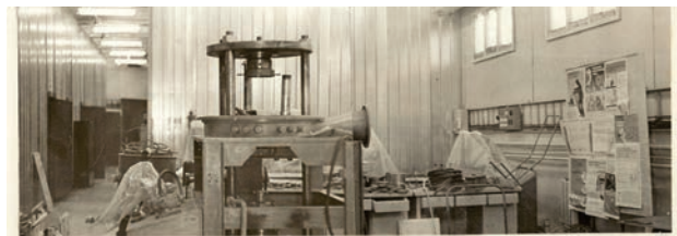
Этап монтажа внутренних перегородок временных строений отдела
