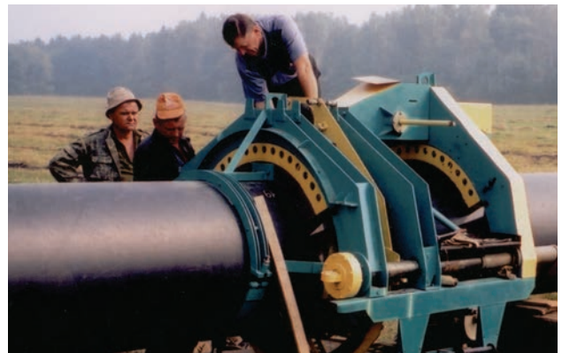
Сварка нагретым инструментом встык полиэтиленовых труб наружным диаметром 800 мм с применением модернизированной установки конструкции ИЭС им.Е.О.Патона при реконструкции стального дюкера диаметром 900 мм, проложенного по дну Южного Буга близ г.Винницы
