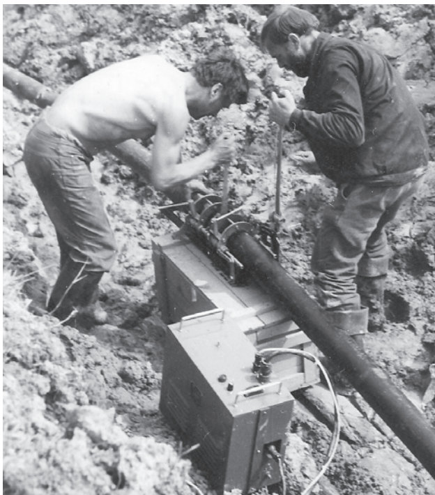
Сварка полиэтиленовых труб наружным диаметром 110 мм на установке типа ОБ 2207 в полевых условиях (июнь 1980 г.)
