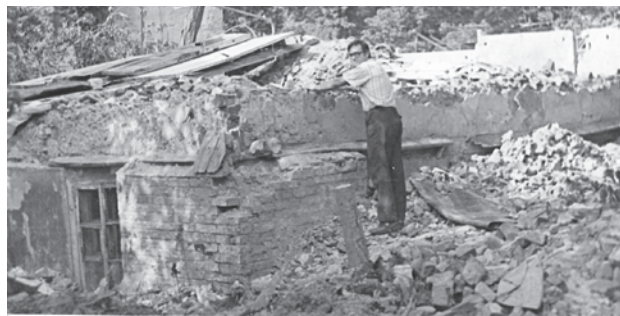
Расчистка участка для строительства новых зданий отдела (1979 г.)
