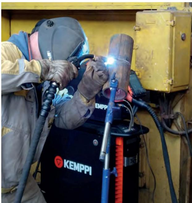
Рис. 8. Процесс выполнения сварного шва сварщиком лаборатории сварки завода Долженко Р.В. трубы Ø 114 x10 мм (положение при сварке J-L045)
