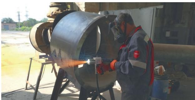
Рис. 2. Ремонт локального дефекта на вкладыше ПЖТ валка прокатного стана 1700 ЧАО «ММК им. Ильича»
