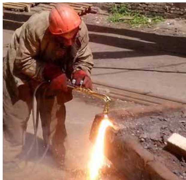
Рис. 17. Домнаремонт, г.Краматорск. Кислородно-флюсовая резка чугуной плиты толщиной 240 мм. Процесс резки заготовки
