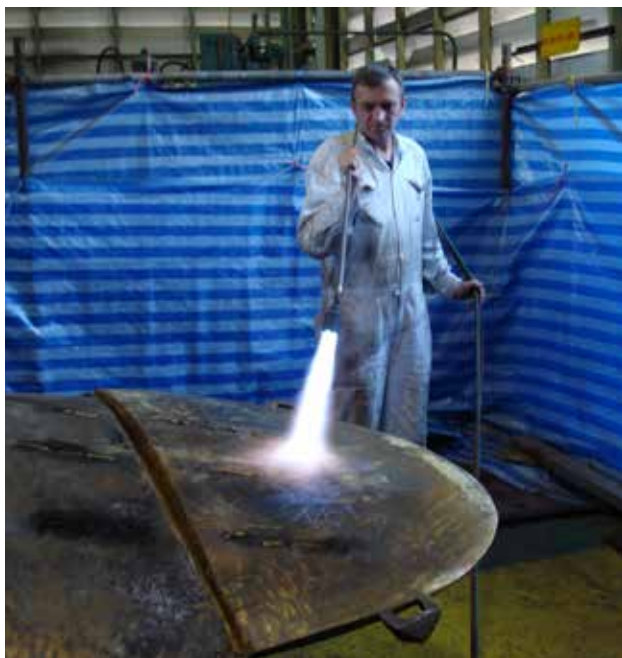
Рис. 2. Обжиг и зачистка зоны сварки и околошовной зоны (ЗТВ) от загрязнений, перед сваркой
