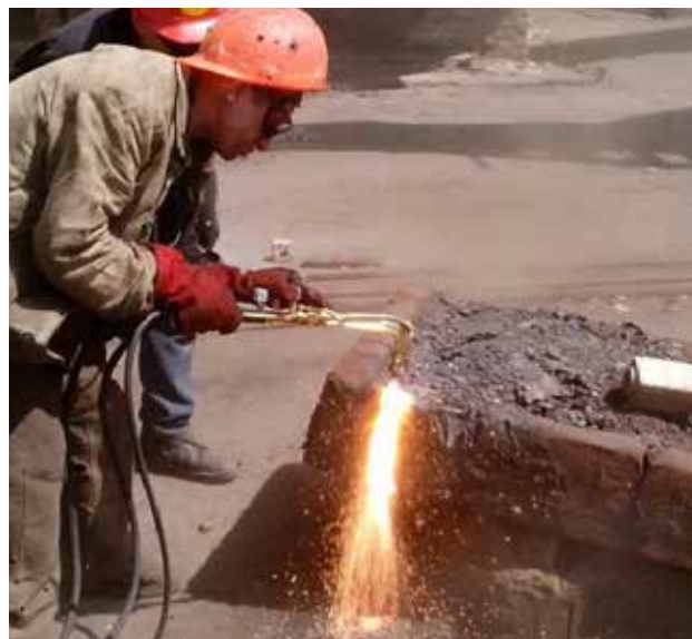
Рис. 16. Домнаремонт, г.Краматорск. Кислородно-флюсовая резка чугуной плиты толщиной 240 мм. Процесс врезания в заготовку
