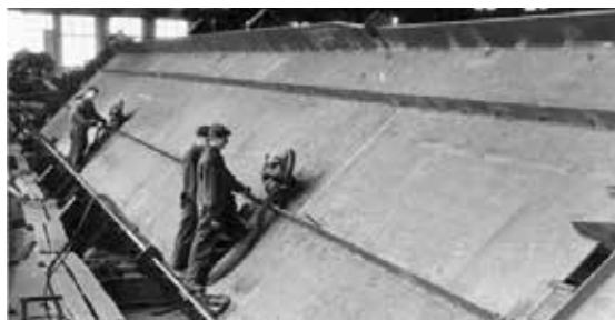
Сварка балки для моста им. Е.О. Патона на Днепропетровском заводе металлоконструкций, 1952 г.
