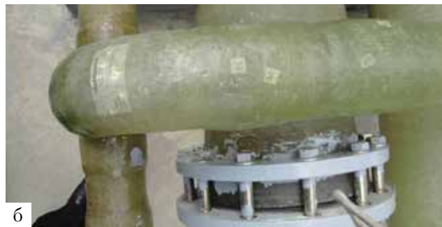
Рис. 2. Полиэтиленовые трубы ламинированные (а), стеклопластиковые трубы (б)
