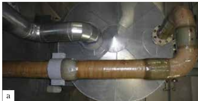
Рис. 2. Полиэтиленовые трубы ламинированные (а), стеклопластиковые трубы (б)
