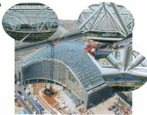
Рис. 14. Приклади використання алюмінієвих сплавів в будівництві мостів (а) та громадських споруд (б). Для з'єднання труб (сплав 6061-T6, максимальний Ø 227 мм) з кінцевими пуансонами застосовували технологію зварювання третям з перемішуванням [27]
