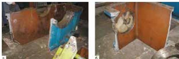
**Пример 2.** Ремонт основания редуктора главного привода эскалатора ЭТ30.
