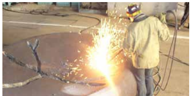
Рис. 22. Разделка трещин на холодной поковке
